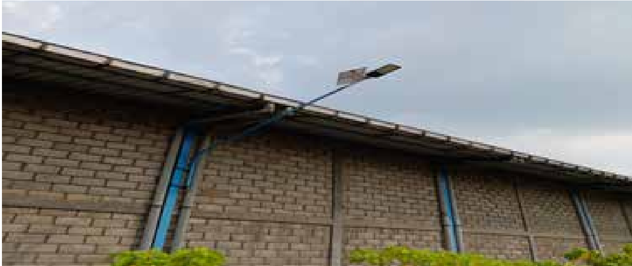
Gambar : Penggunaan Lampu jenis lampu solar Panel | Image: Use of solar panel type lamps
